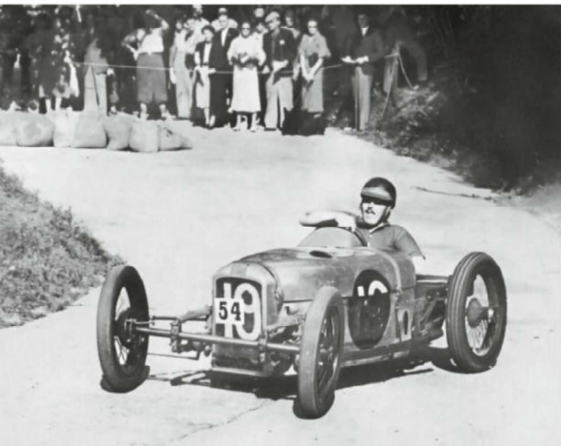
Bolster Bloody Mary 1. El primer modelo fabricado por John Bolster, que evolucionó mucho desde su creación en 1928. Al principio no tenía suspensión delantera y el motor era un V2 JAP de 1914, después instaló dos motores enlazados por cadena. El bastidor estaba hecho de tres largueros de fresno y fue mejorando con el tiempo. Bolster lo utilizó durante varias décadas con éxito. Actualmente está expuesto en el National Motor Museum de Beaulieu (Inglaterra).
